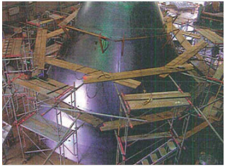
大型バグフィルターセルプレート加工
